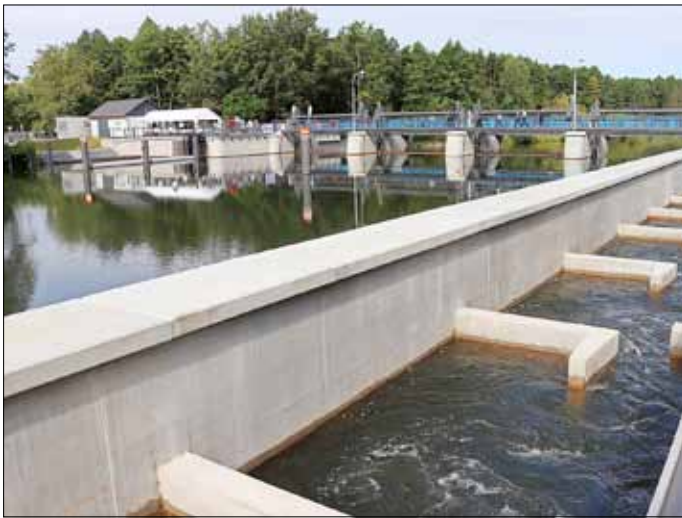
Der Fischpass ist rund 80 Meter lang und lässt bis zu 1,60 Meter große Fische durch.
